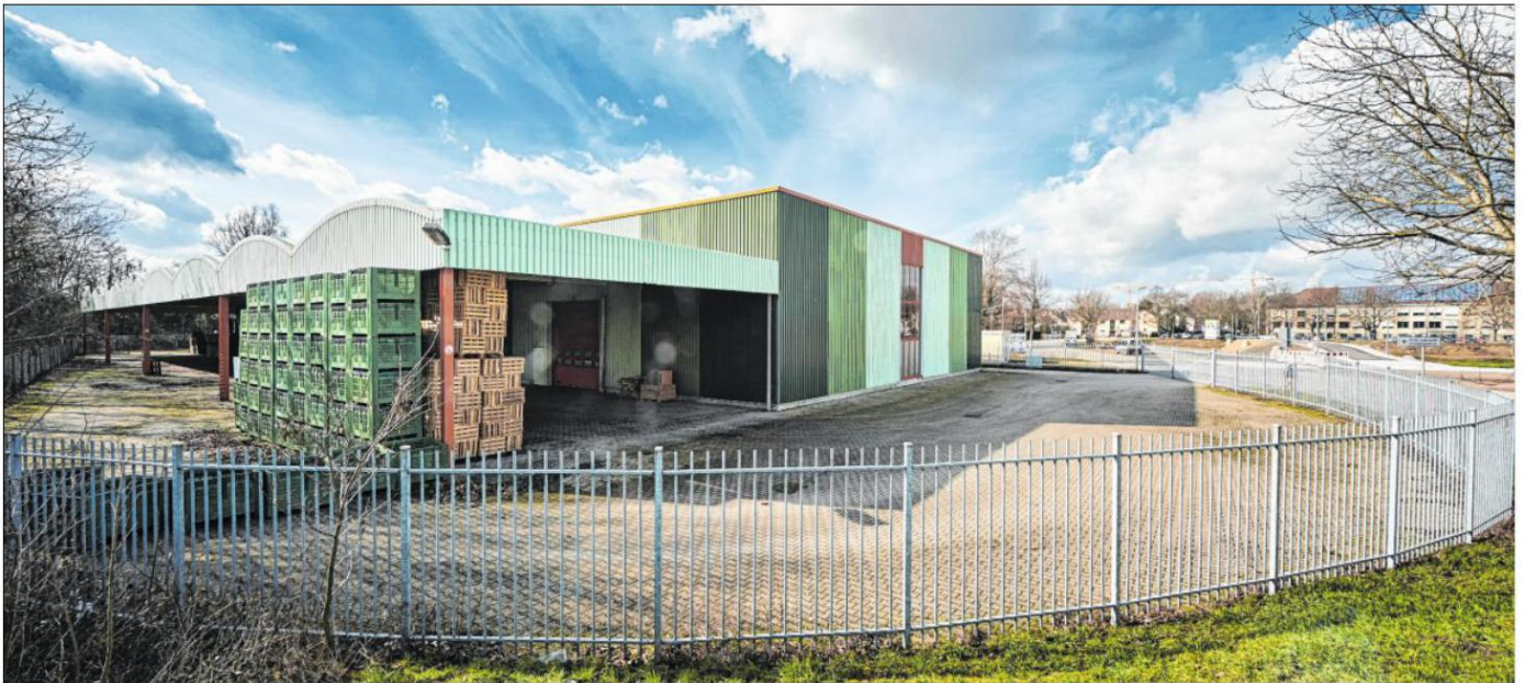
FÜR EINE NEUANSIEDLUNG in der Bruchsaler Bahnstadt sorgt die Kommune jetzt selbst. Auf dem Gelände einer ausgedienten Halle der OGA Nordbaden soll nach einem Beschluss des Gemeinderates die lange geforderte neue Sporthalle gebaut werden. Stadtrat Hartmut Schönherr (Grüne/NK) regte gar ein OGA-Namenssponsoring an. Foto: Heintzen
