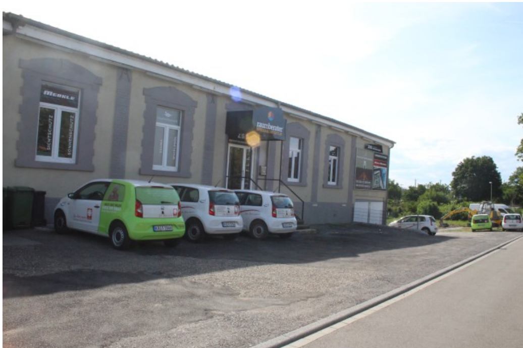
Abbildung 1: Gebäudefront von Norden
