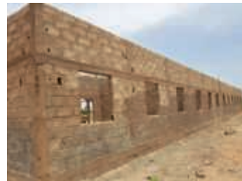
Jetzt kann die Dachkonstruktion kommen! Foto: Konvoi
