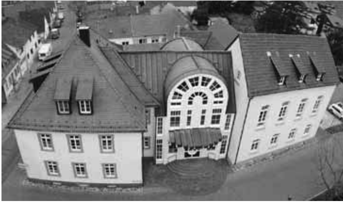
Das Jägerhaus in Forst. Der Anbau (rechts) wurde als Zigarrenfabrik von Salomon Rothheimer um 1900 erbaut. Foto: Landfunke RegioNews 2021.
