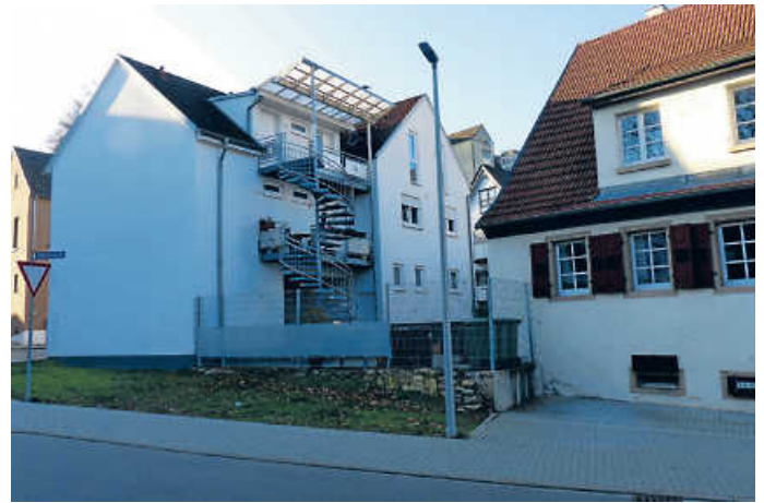
Die Fläche nach Hausabriss und Straßenausbau bildet den Rebstöckleplatz Foto: goe
