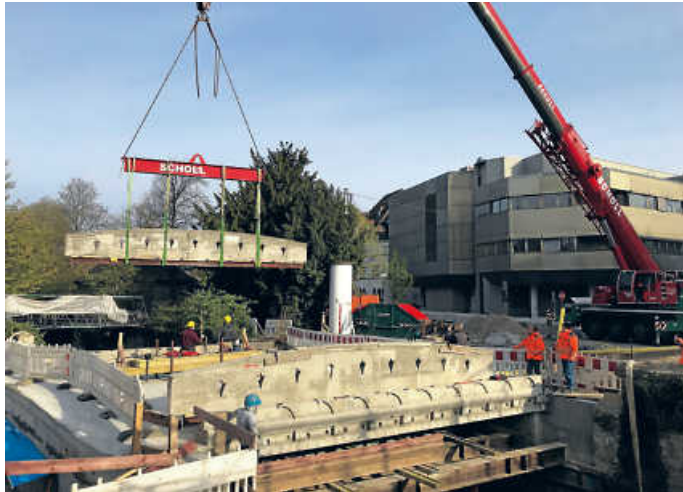
Die Brüstung ist wieder an der Saalbachbrücke montiert Foto: PM
