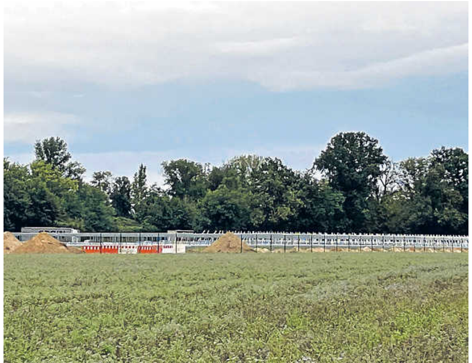
Bau des Untergrombacher Solarparks an der A5
