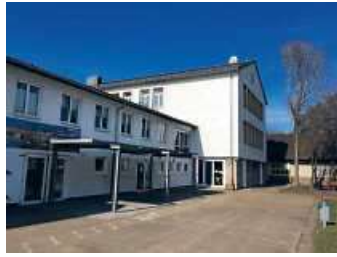
Die Karl-Berberich-Schule Bruchsal nach der Generalsanierung Foto: Ira
