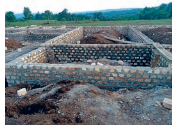
In Uganda werden die Fundamente mit Ziegelsteinen gemauert
