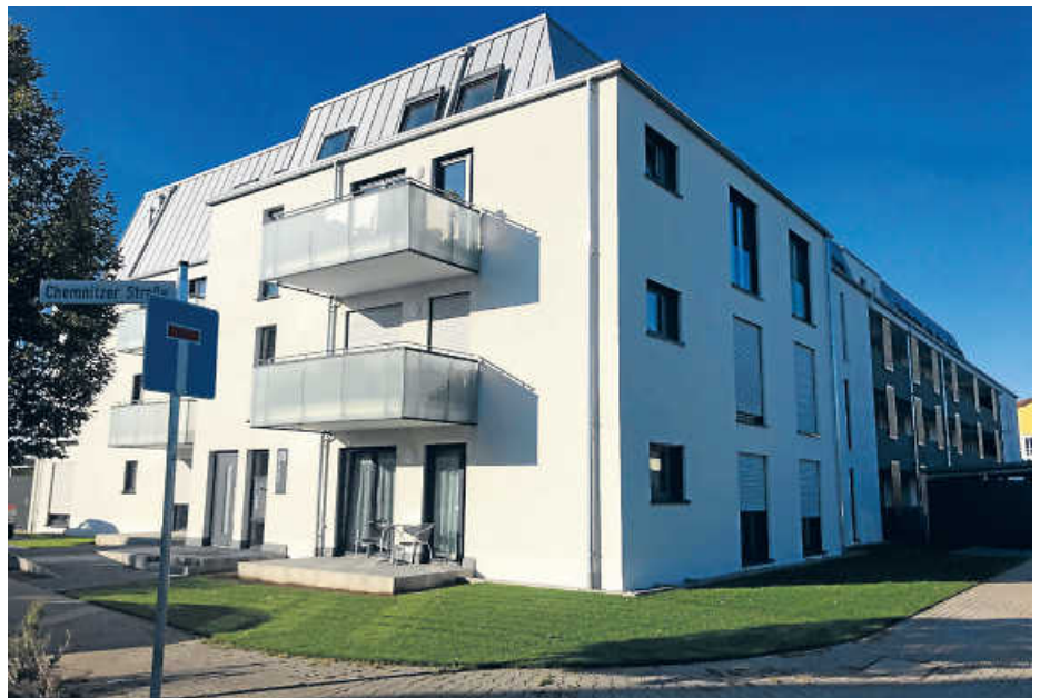
Rund 30 Mietparteien werden im Rahmen des Wärme-Contractings der Stadtwerke mit Wärme versorgt.
