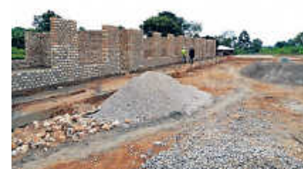
Bau-Ingenieur mit unserem Projektpartner beim Kontrollgang
