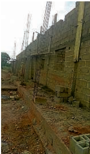
Die Außenmauern stehen bereits am neuen Gymnasium in Afrika. Foto: Konvoi der Hoffnung
