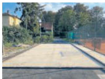
Bouleplatz TF Bruchsal Foto: TS
