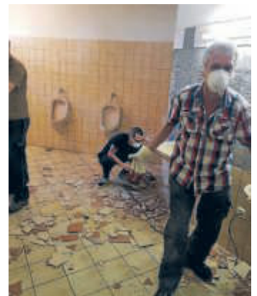
Toilettensanierung unter Hygienevorschriften Foto: MVO
