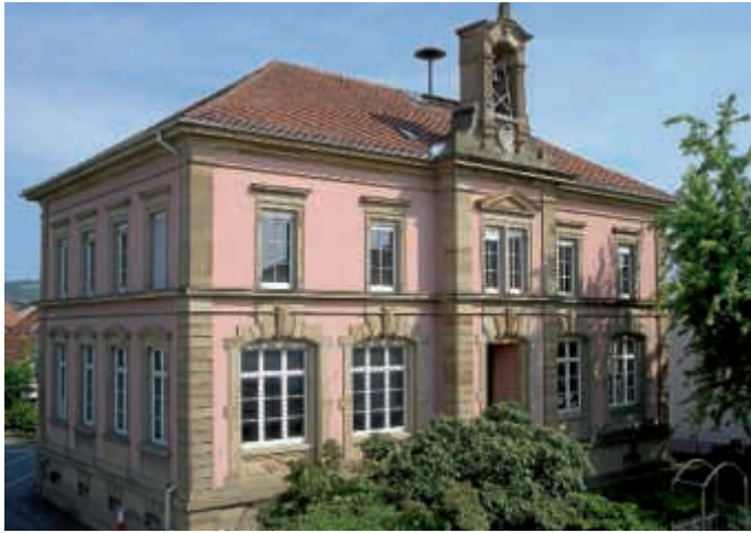
Das Alte Schulhaus in Büchenau
