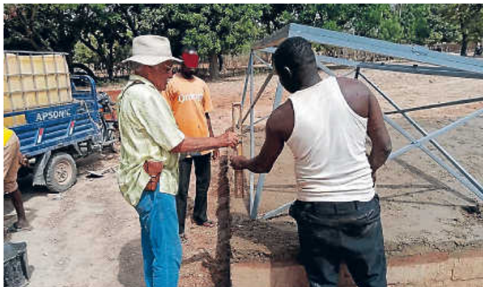
H. Bauer beim Aufstellen des Solarmodul-Ständers am Schullehrgarten Foto: St. Souli
