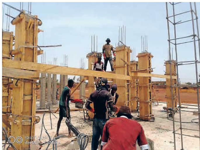
Letzte Woche wurden die Stützpfeiler im Erdgeschoss betoniert
