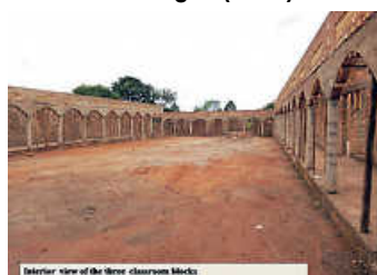
Uganda: Schule im Rohbau, jetzt kommt das Dach drauf
