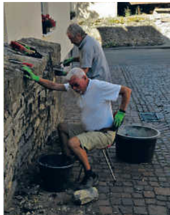
Ausfugen der Stadtmauer
