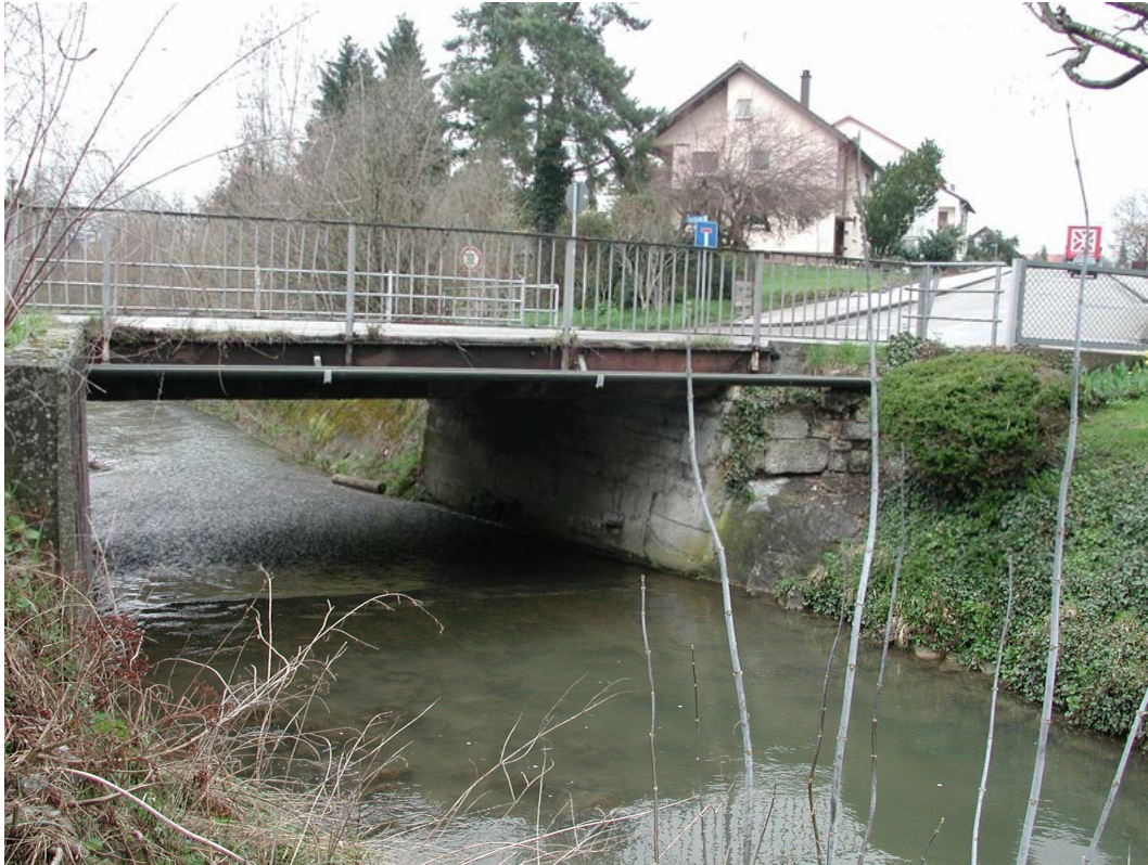
Ersatzneubau Altenbergbrücke mit Kanal-Tieferlegung
