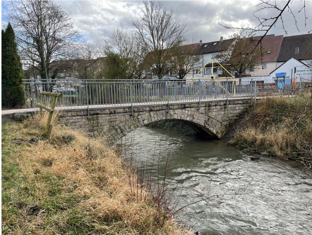
Ersatzneubau Fußgängerbrücke Zehntgasse / Mittlere Mühle
