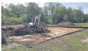
Das neue Beachtennisfeld ist bereits ausgegraben Foto: Tennisclub Blau-Weiß Untergrombach
