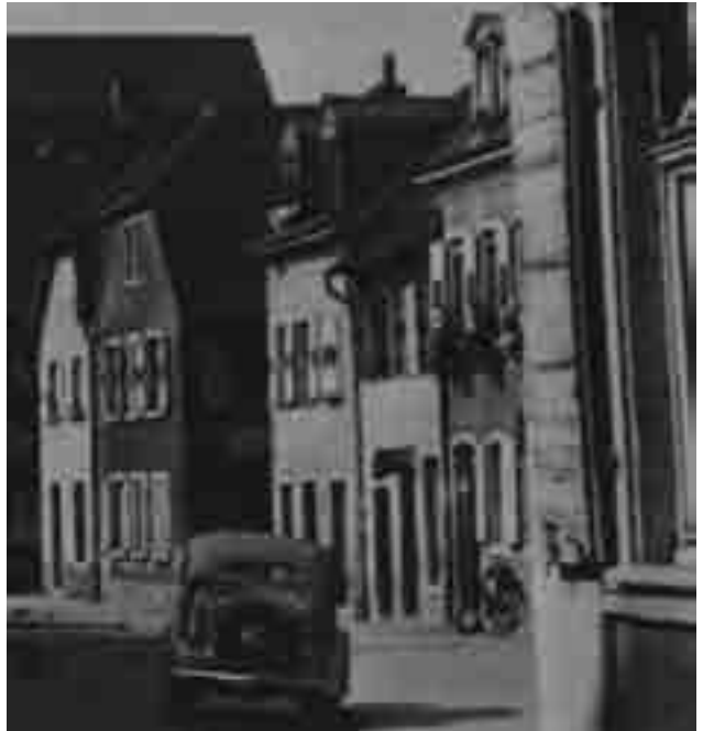
Durlacher Straße in Bruchsal, von links die Hausnummern 30, 28, 24, 22, 20; im Vordergrund 10, um 1935. Zwischen 28 und 24 liegt das Gässchen zur Nr. 26 (vgl. S. 9). Foto: Nachlass Karl Eichhorn.
