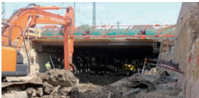
Am Bahnhof Bruchsal gehen die Arbeiten voran.
