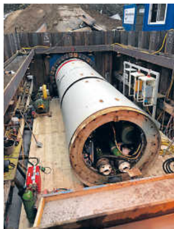
Die vollautomatische Tunnel-Bohrmaschine schafft sich durch das Erdreich Foto: PM
