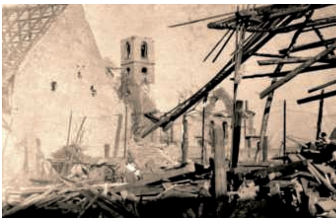
Die zerstörte Pfarrkirche St. Bartholomäus nach dem Luftangriff auf Büchenau am 2. Februar 1945
