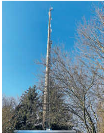
Aktueller Standort an der Robert-Stolz-Straße in Obergrombach – dieser bleibt durch die Telekom erhalten Foto: Hardock
