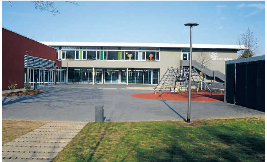
Die Joß-Fritz-Schule im Bruchsaler Stadtteil Untergrombach.
