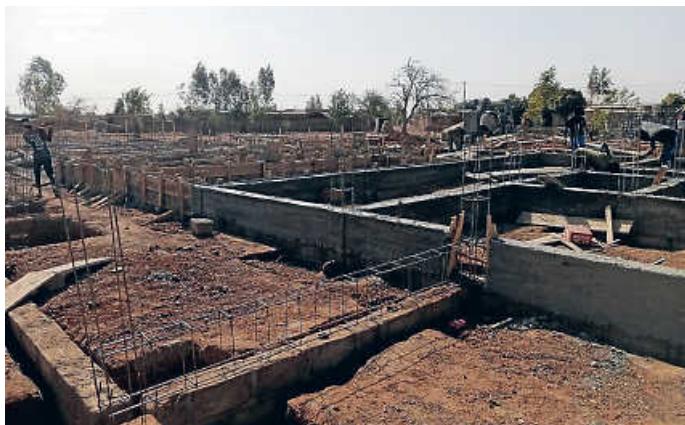
Klinikbau Burkina Faso: Letzte Woche wurden die Sockel betoniert
