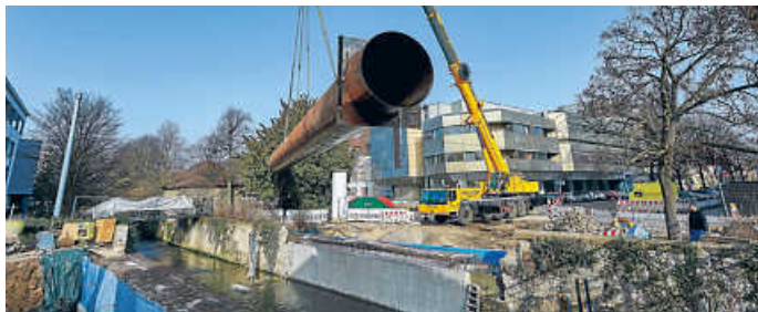
Mit einem Autokran wurde das Stahlrohr gehoben Foto: Heintzen
