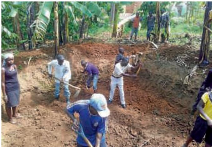
Kyambulibwa, Uganda: Ausschachtungsarbeiten für die Bodenplatte des Schulbaus.
