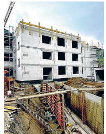
Erweiterungsbau des Seniorenzentrums Bundschuh
