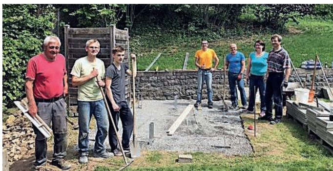
Unser fleißiges Team beim Bau der neuen Familienumkleide (Foto: Uwe Lindenfelser)
