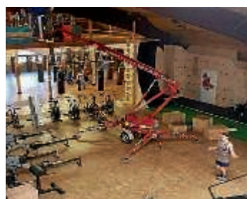
Hallensanierung Foto: Pugilist Boxing Gym
