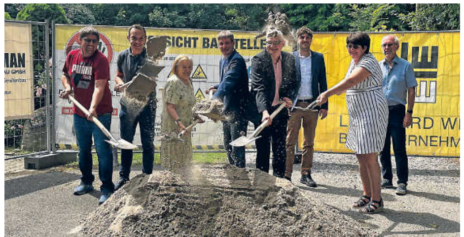
Es war ein symbolischer Spatenstich mit dem jetzt der Breitbandausbau im Langental auf den Weg gebracht worden ist. Foto: PRIK
