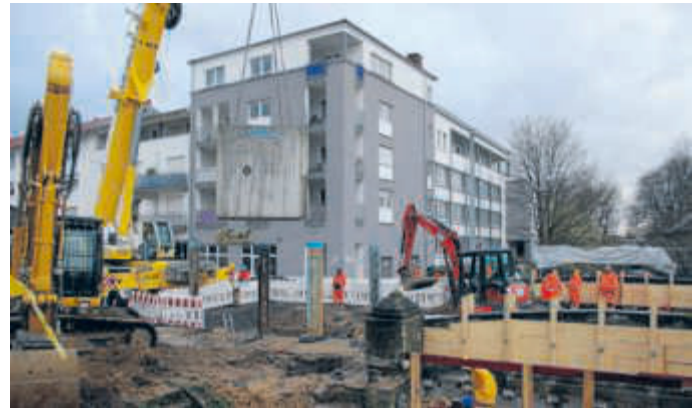
Per Kran wird das massive Kanalbauteil in die Erde eingelassen
