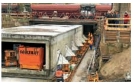
Der finale Durchstich der Gleisquerung.
