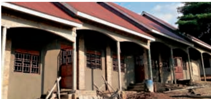
Die im Bau befindliche neue Schule in Kyamulibwa/Uganda Foto: pr
