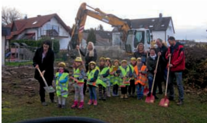
Spatenstich für den Erweiterungsbau
