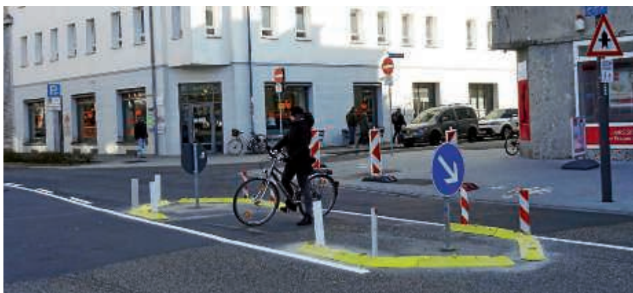
Umbau der Amalienstraße zur fahrradfreundlichen Straße fertiggestellt.
