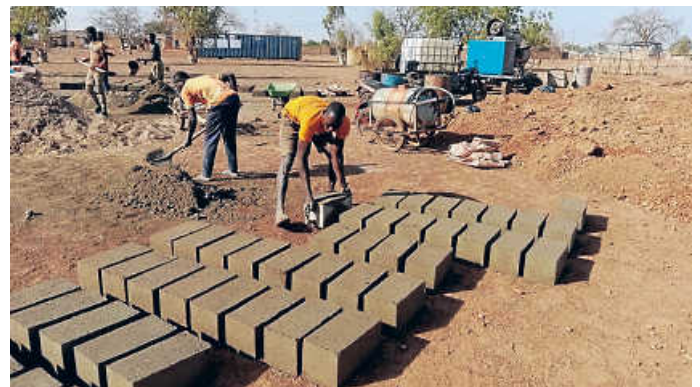
Mauersteine für die Klinik manuell gefertigt
