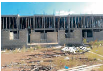
Unser Krankenhaus-Rohbau macht Fortschritte Foto: T. Nakelssse
