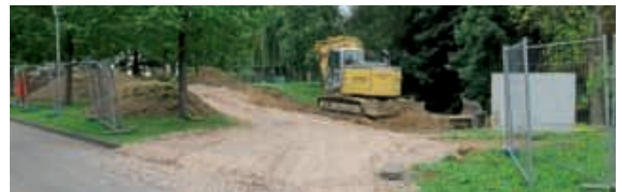
Baumaßnahme hat begonnen und wird voraussichtlich im Dezember 2017 abgeschlossen sein. Foto: pa
