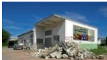
Der neue Haupteingang ist bereits freigeräumt Foto: Exil Theater
