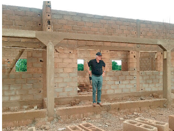
Dr. Pflücke „inspiziert“ die Schulbaustelle in Burkina Faso!
