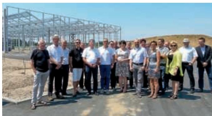
Baustellenbegehung „Im Brühl“ am 21. Juni
