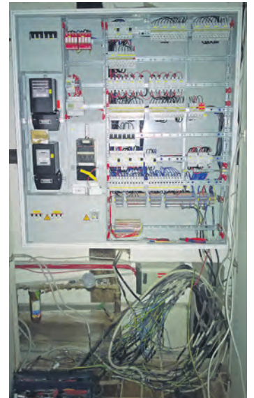
Einbau des neuen Sicherungskastens
