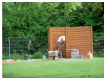
Verlegen der Bodenplatten
