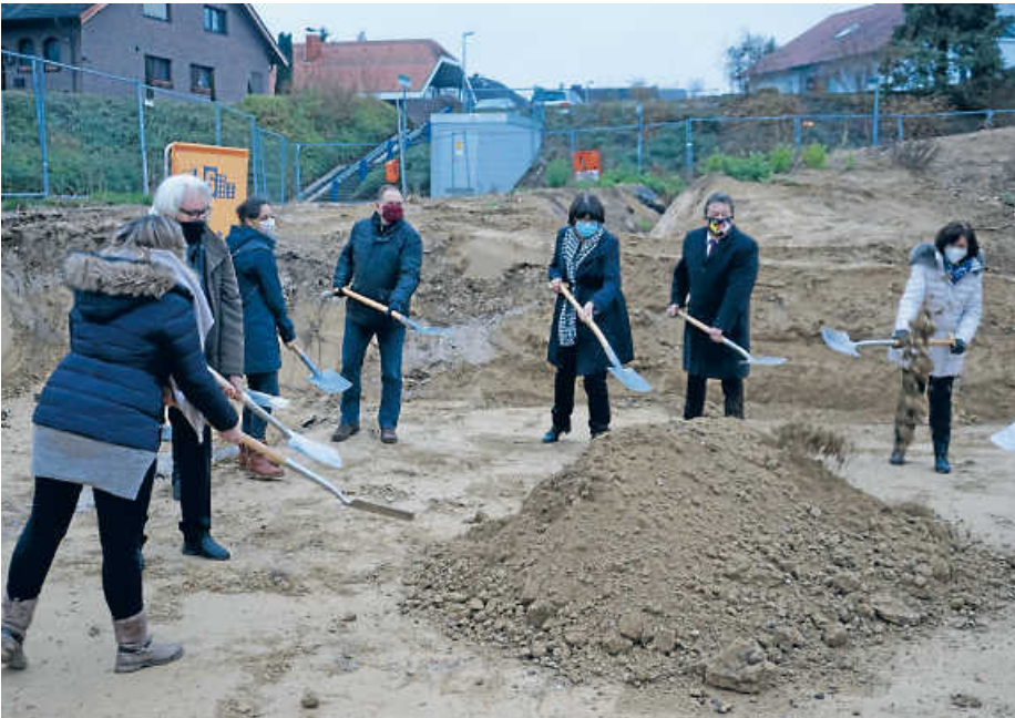
Mit dem Spatenstich „Guter Hirte“ beginnt die Realisierung des Neubaus für das evangelische Gemeindezentrum. Foto: Hübner
