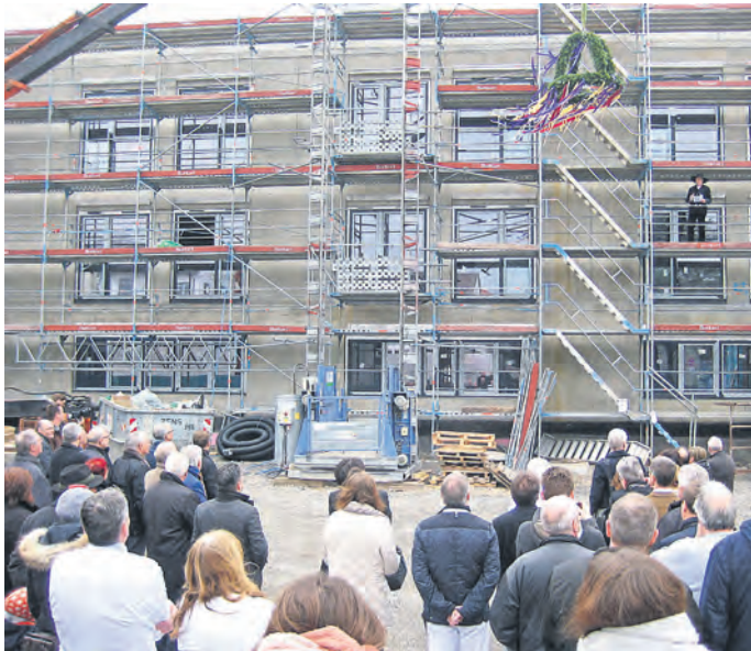
Richtfest für den neuen G-Bau an der Fürst-Stirum-Klinik Karlsruhe.
