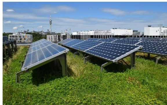
Abb. 4: Kombination aus Dachbegrünung und Solar, BuGG Bundesverband GebäudeGrün e.V.
