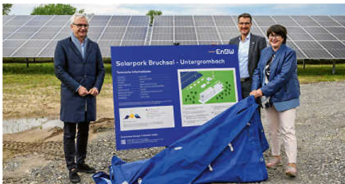
Der Solarpark der EnBW in Bruchsal mit Batteriespeicher wurde eingeweiht Foto: ARTIS Uli Deck
